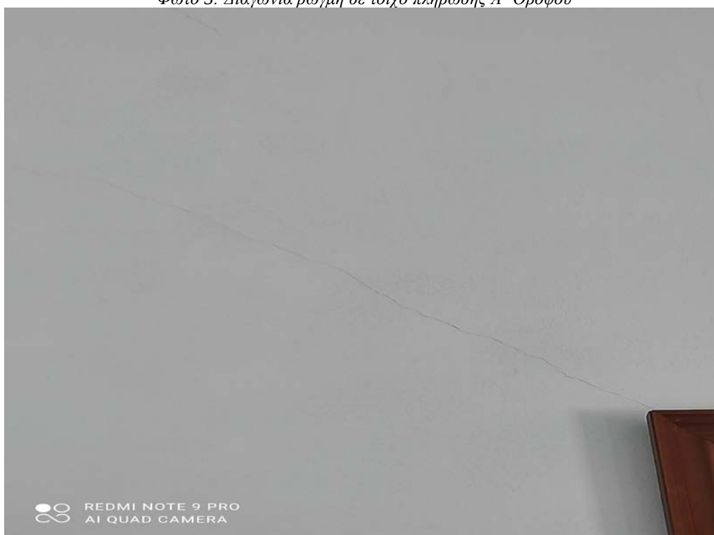
Φωτό 3: Διαγώνια ρωγμή σε τοίχο πλήρωσης Α' Ορόφου
