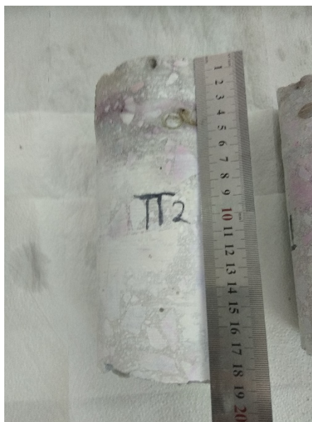
Εικόνα 2. Θέση 2 Picture 2. Location 2
